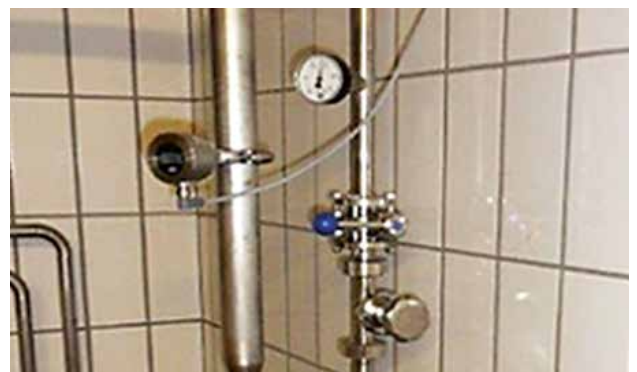
GTL 737 monitorizează temperatura berii într-un sistem de răcire pentru echipamentul de distribuire în butoi
